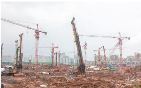
（施工现场图片）
